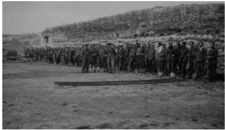
FIG. 2 : Début des travaux à Ampurias 12/09/1940 : le bataillon de travailleurs Figueras 71 devant la Muralla Robert . Installation de la voie ferrée pour le déplacement des wagonnets destinés au transport des déblais.
