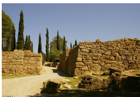
FIG. 2 : Mur d'enceinte de l'oppidum d'Ullastret.
