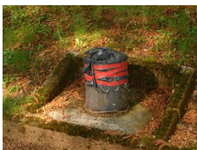
Fig. 7 Lampadaires défectueux à la Promenade des Vignerons.
