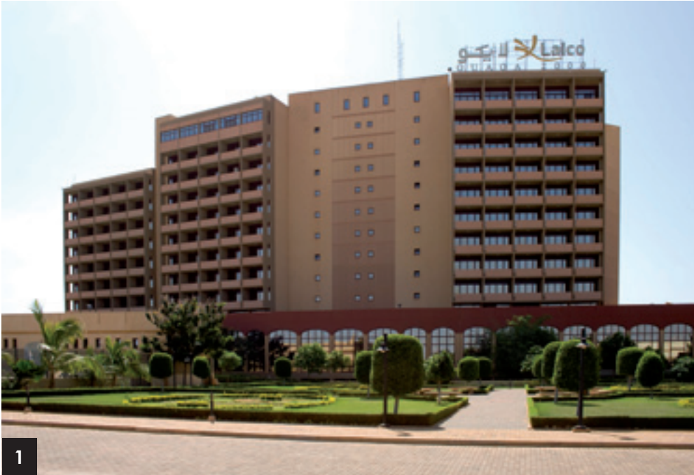
Hôtel Libya et Centre commercial El Fateh 1 Hôtel vue du Parc
