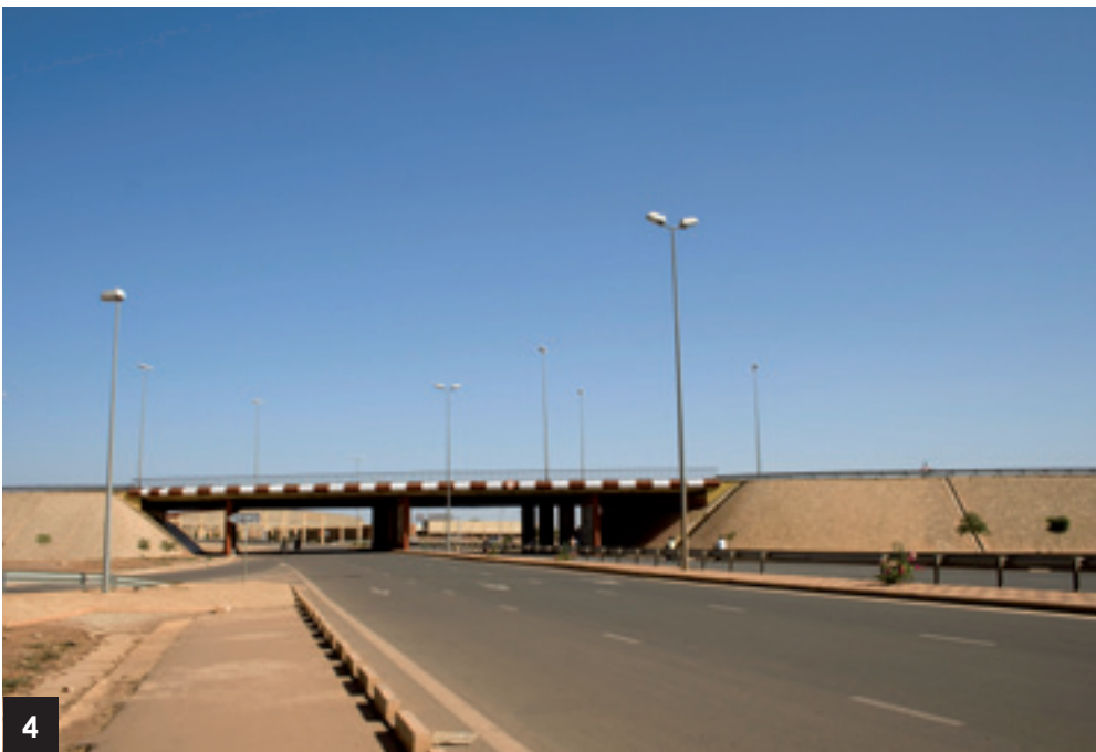
Echangeur du sud 4 Vue Sud près
