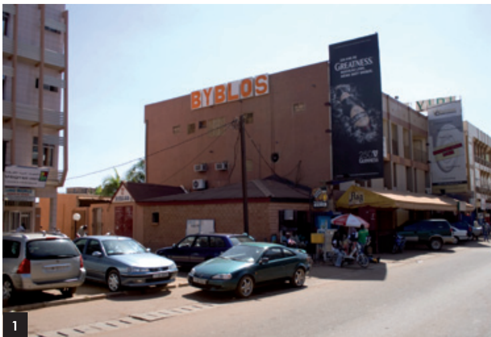
Boîtes de nuit Byblos et Papagayo 1 Vue d'ensemble du bâtiment
